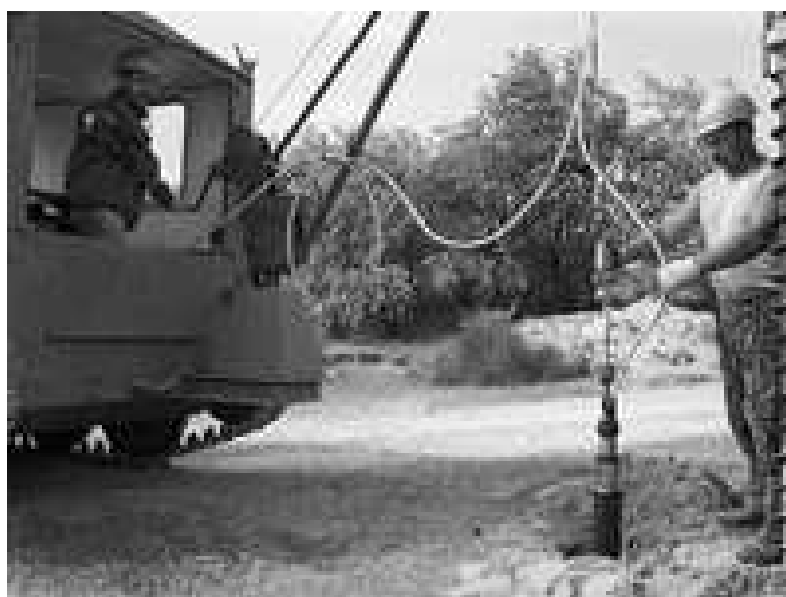
Рис. 12 Установка для бурения скважин на базе транспортера ГТС Возбуждение упругих колебаний на чистой воде производится с
